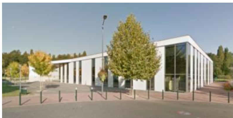
Gymnase Colette Besson – Quartier du Canal
